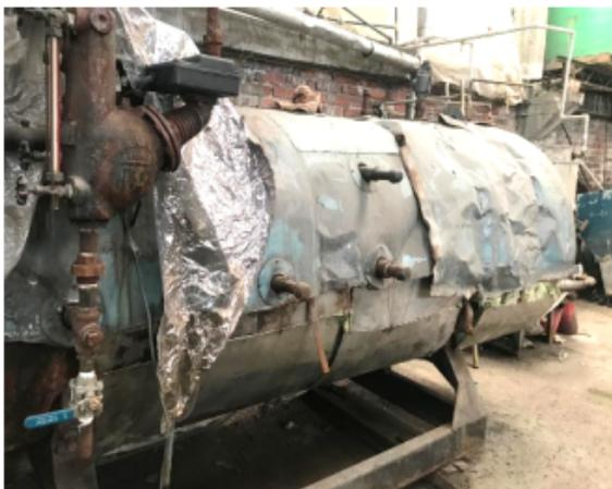
Fotografía 7. Caldera marca Colmáquinas de 40 BHP (deteriorada)
